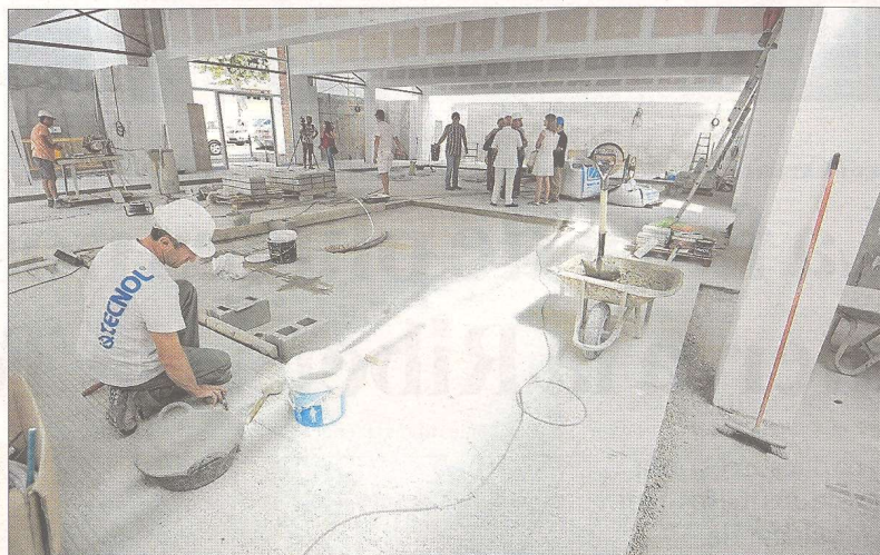
Visita d'obres, ahir al matí al Mercat Municipal d'Alcanar. FOTO: JOAN REVILLAS
