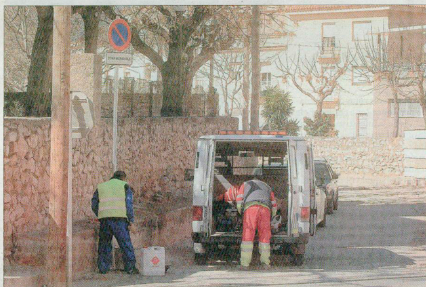
Operaris municipals van instal·lar, ahir al migdia, el senyal de prohibició al barranc de la Llet. FOTO: JOAN REVILLAS
