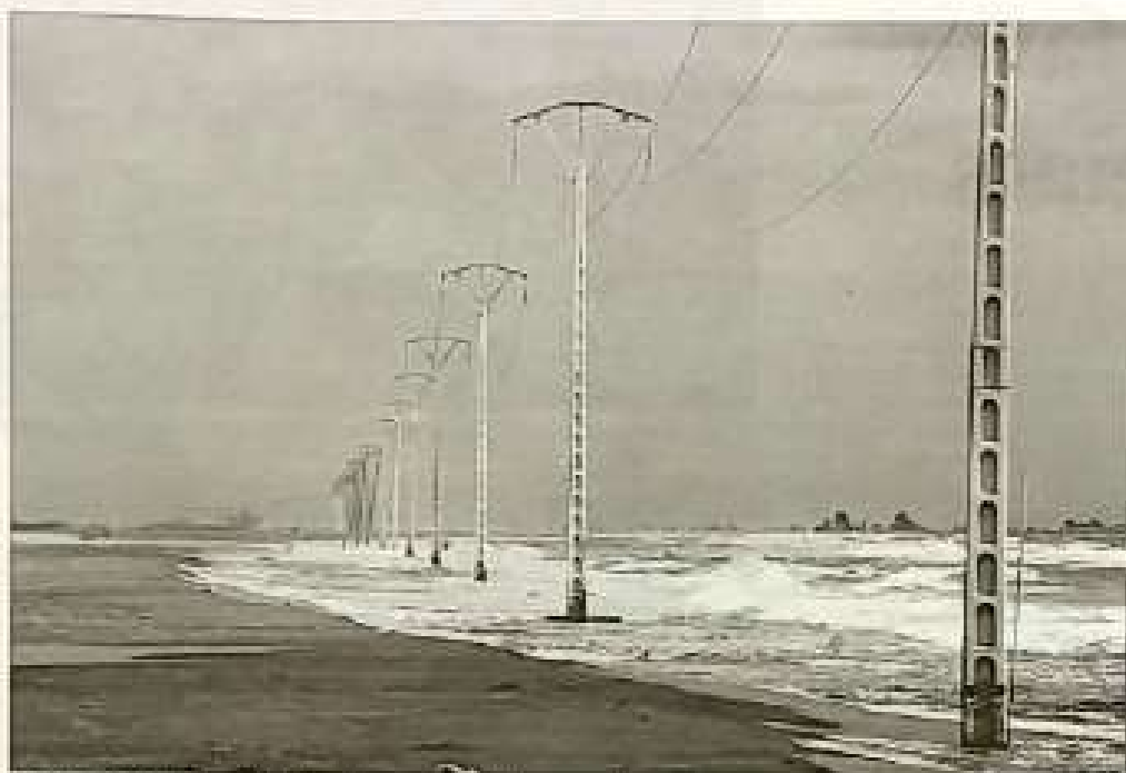
L'antiga línia elèctrica del Trabucador, que s'ha de desmantellar. FOTO JUAN VILLAS
