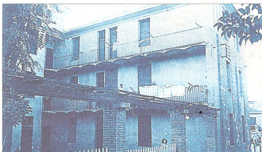
Un dels habitatges dels treballadors de la colònia.
