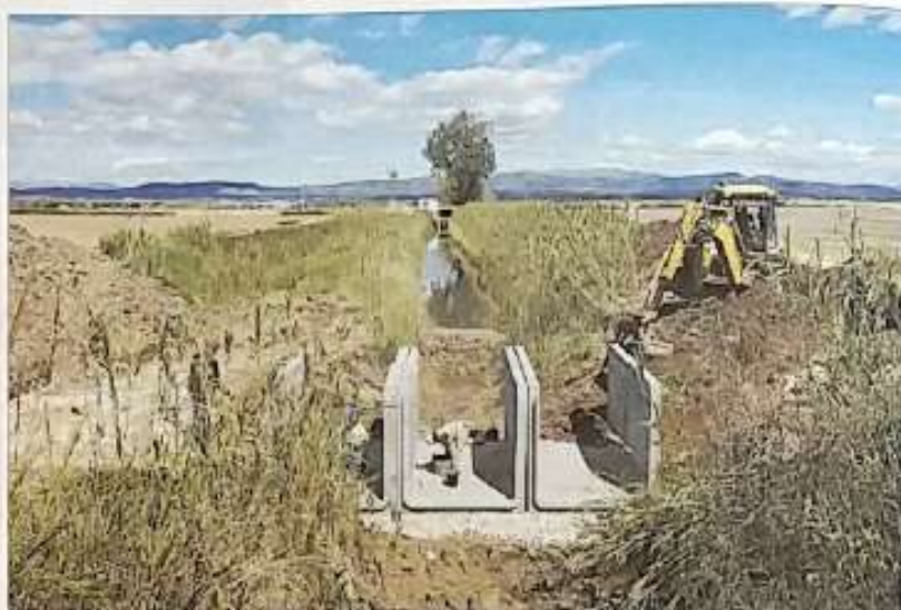
Instal·lació de la infraestructura necessària per als filtres. FOTO: JOAN BELLAS
