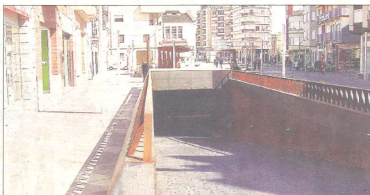
El punt de recàrrega serà instal·lat a la zona del mercat d'Amposta.
