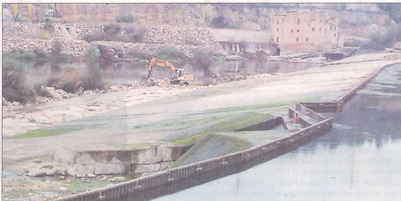
Màquines al peu de l'assut, on se n'està allargant el reforç amb blocs d'escullera aquesta setmana. / Ò.M.J.
