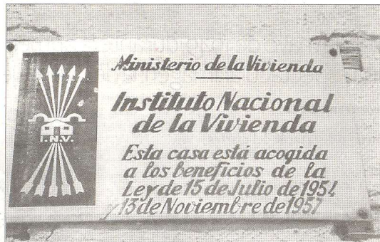
Placas en 521 edificios de la provincia. - Es, de calle, el elemento más abundante. Hay registradas 453 placas en el Camp de Tarragona y 59 en las Terres de l'Ebre. Destaca la firma del Instituto Nacional de la Vivienda y el yugo y las flechas, símbolo franquista por excelencia. FOTO: DT
