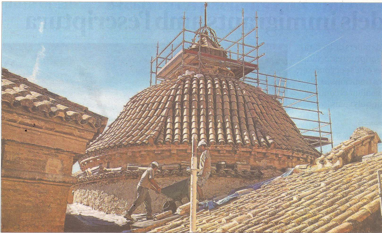
Operaris de l'empresa encarregada de les obres, ahir a la coberta de la capella del Sant Crist. FOTO: JOAN REVILLAS
