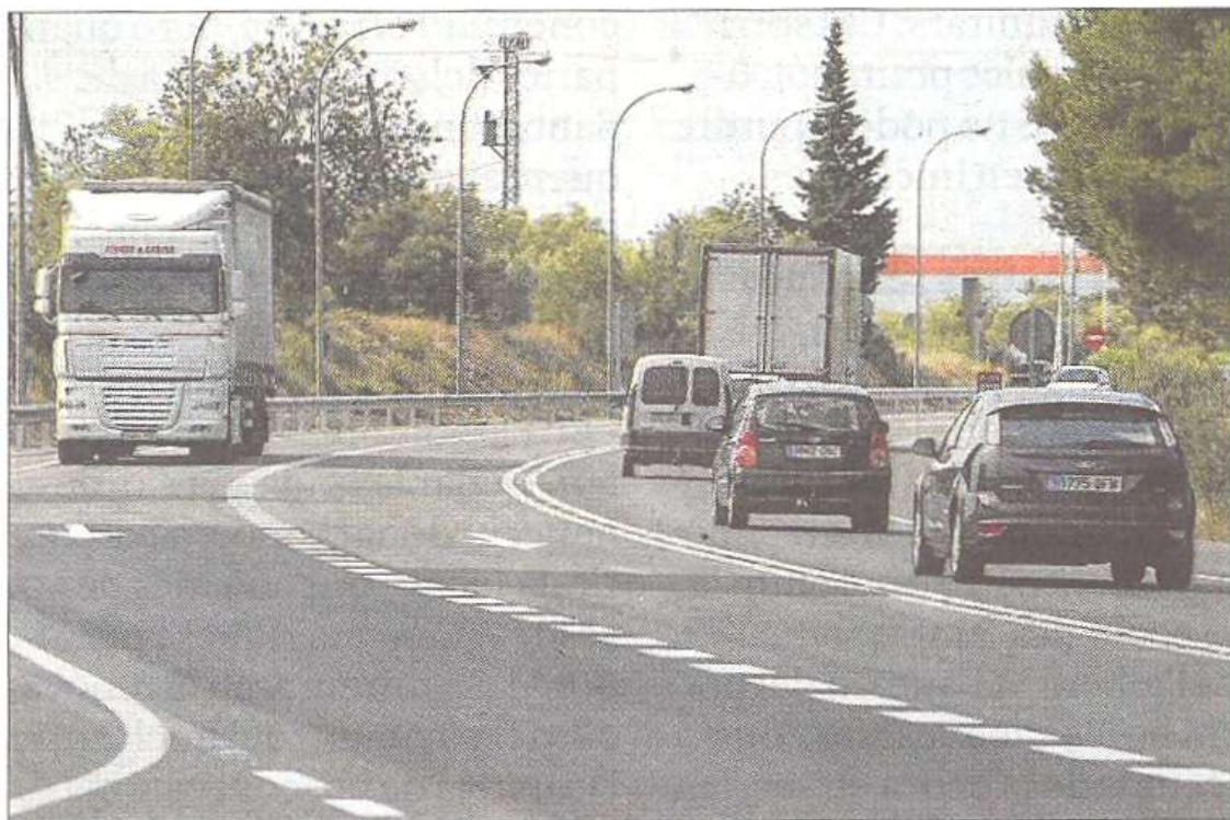
Imatge d'un dels trams de la N-340 a les Terres de l'Ebre, amb tres carrils i el tipus de mitjana que ara es vol adequar. FOTO: JOAN REVILLAS
