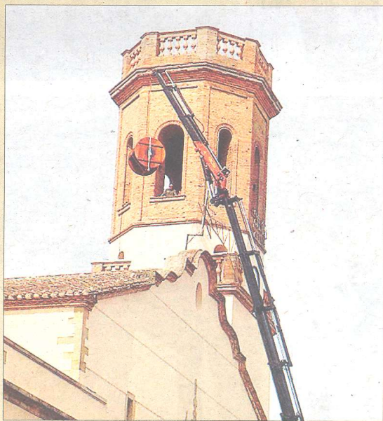
Maqueta de la matraca que més tard va ser construïda en mides molt superiors. A la dreta, la matraca, en el moment de ser pujada per una grua al campanar. Cal ressaltar que l'aparell fa un metre d'ample i l'ull del campanar per on va entrar medeix 1,10 metres. / V.C. / CEDIDA
