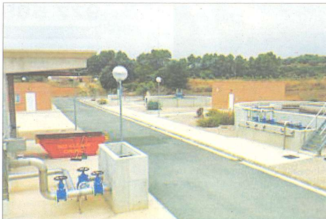
La depuradora d'Horta de Sant Joan, construïda per Acuamed. / CEDIDA
