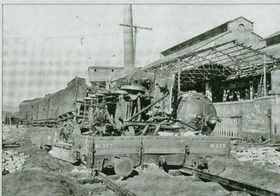
Tren destruït al complex químic de Flix arran del bombardeig del 23 de febrer de 1937. FOTO: ARXIU DE FLIX. FONS ÒSCAR KURZ
