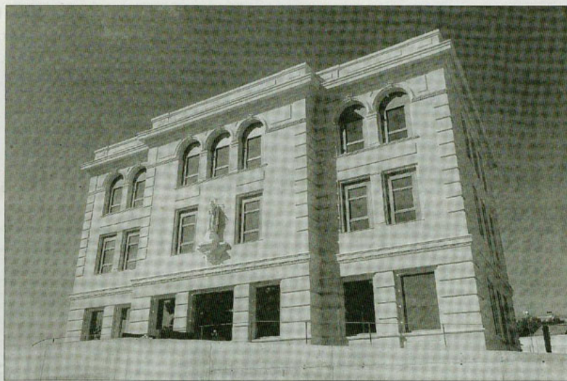
► Estat actual de la façana exterior de l'edifici, ja restaurada. FOTO: JOAN REVILLAS
