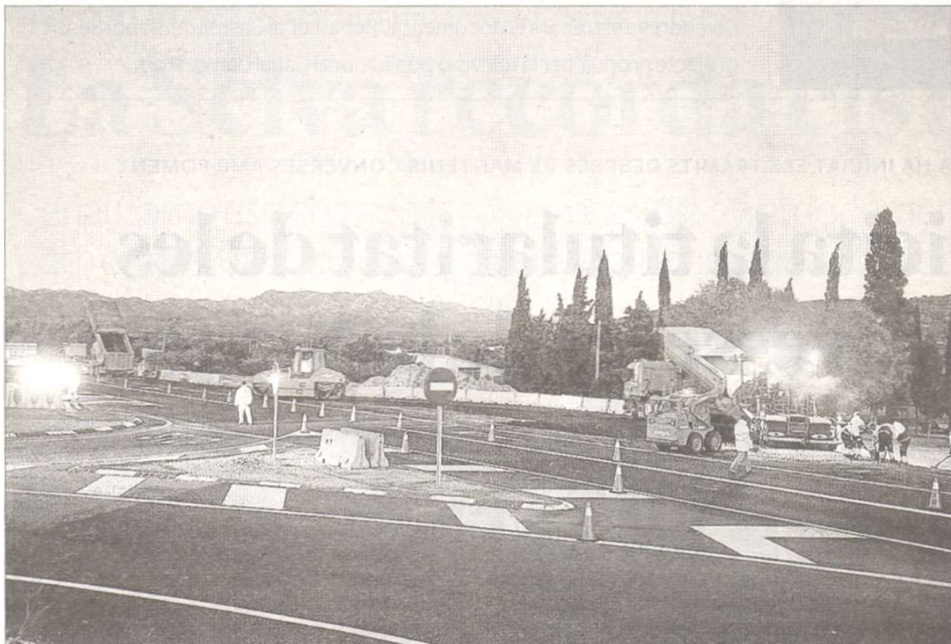
Treballs a la carretera N-340, ahir a la tarda, al Perelló. FOTO: JOAN REVILLÀS
