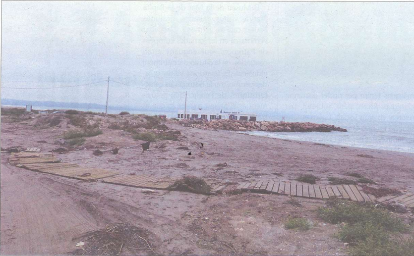
Aspecte que presentava la platja de la Marquesa diumenge passat després de la darrera llevantada. A la foto també s'aprecia com la zona del restaurant està ja envoltada d'aigua per les dos bandes / L.B.
