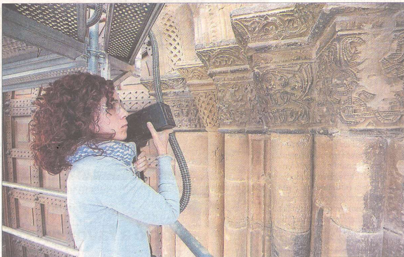
Una de les restauradores treballant a la portalada amb la tècnica làser, ahir al migdia. FOTO: JOAN REVILLAS
