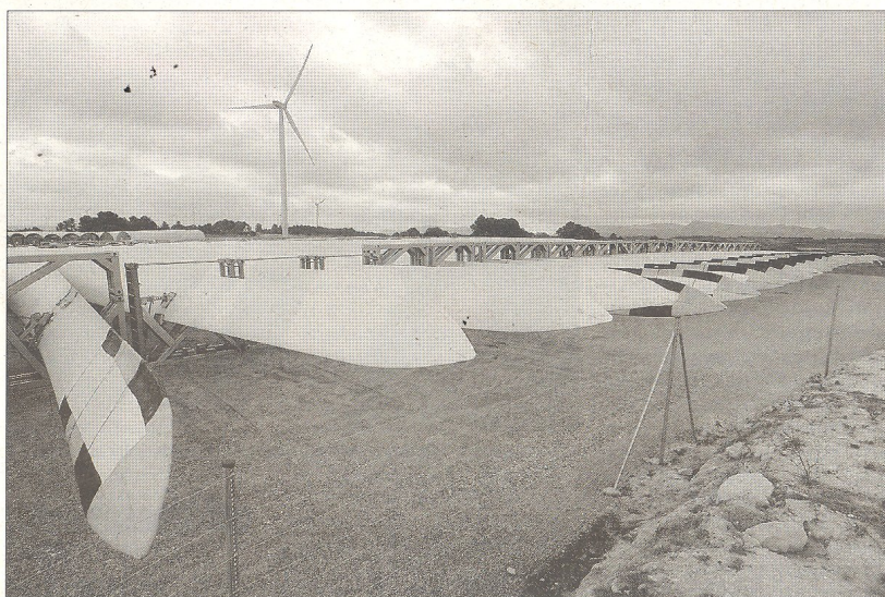
Estesa de pales d'aerogeneradors per al parc eòlic de Coll de Moro, a la Terra Alta. FOTO: J. REVILLAS
