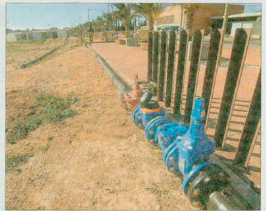
► Obres de connexió, aquesta setmana passada, en un tram de la carretera de Jesús a Roquetes. FOTO: JOAN REVILLAS
