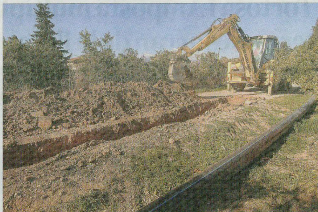
Les obres de connexió de la xarxa d'aigua de Jesús amb Ferreries continuen intensament. FOTO: JOAN REVILLAS
