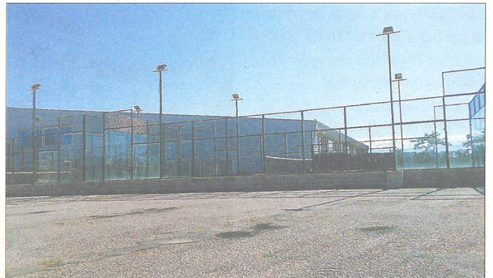
Estat actual de les instal·lacions, que ja porten nou mesos tancades.
