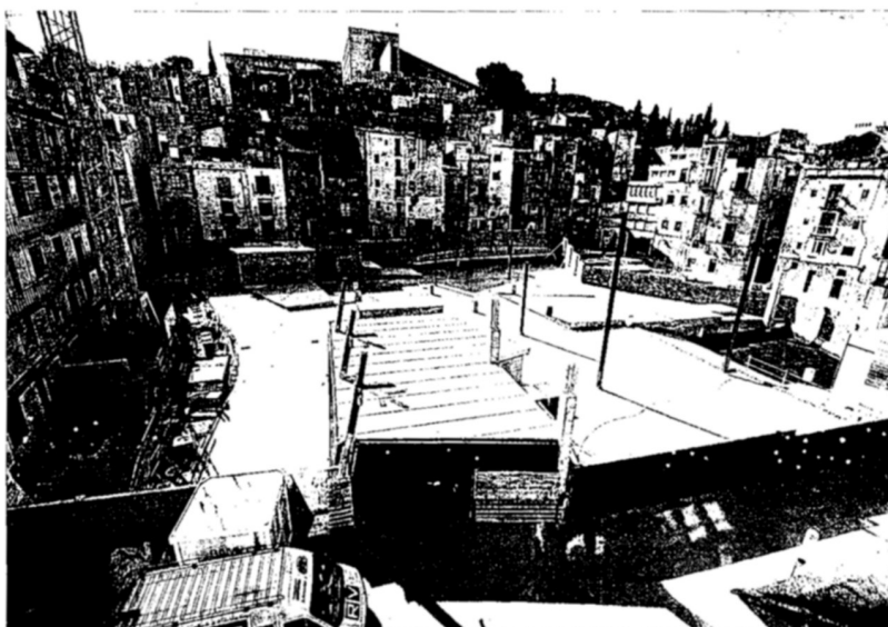
Imatge de la parcel·la al nucli antic de la ciutat on s'ha de construir l'edifici de les Delegacions. FOTO: JOAN REVILLAS
