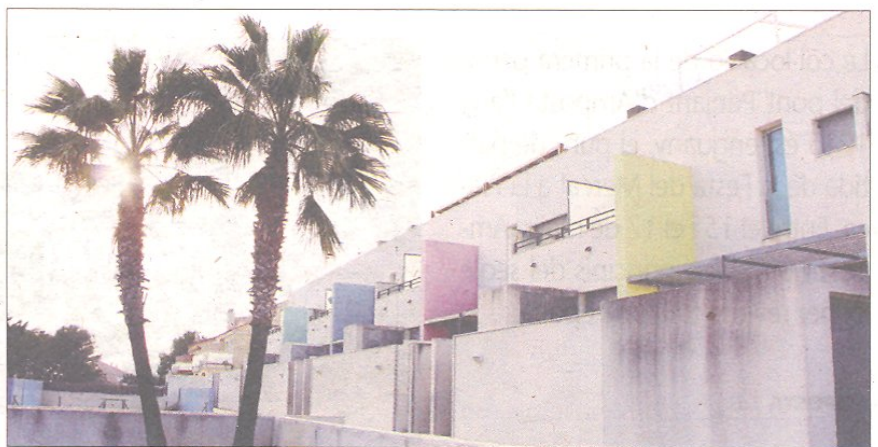
L'edifici Turov està situat a Alcanar Platja. / ACN
