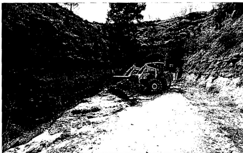
Una màquina retirava ahir al migdia gran quantitat de fang a l'entrada d'un túnel de la via. FOTO: JOAN REVILLAS
