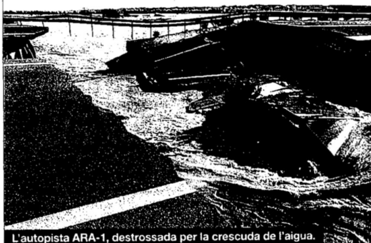
L'autopista ARA-1, destrossada per la crescuda de l'aigua.
