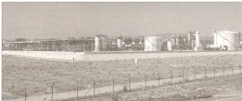
La planta terrestre del Castor, al municipi de Vinaròs però més a prop del nucli principal d'Alcanar.
