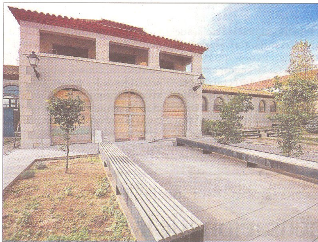
L'edifici havia estat rehabilitat per una escola taller però no tenia cap funció a la ciutat fins ara. FOTO: JOAN REVILLAS
