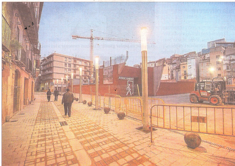
El carrer Montcada i de l'aparcament on al damunt es construirà la seu de les Delegacions. FOTO: J. REVILLAS
