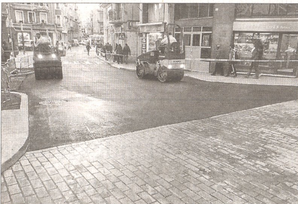
Treballs a la zona del Pont de Pedra, a l'entrada al nucli antic de la ciutat.
