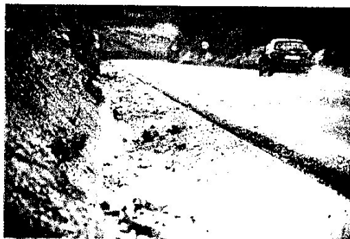
Petits desprendiments de roques a la carretera T-741 a Flix, al nord de la Ribera d'Ebre. FOTO: JOAN REVILLAS
