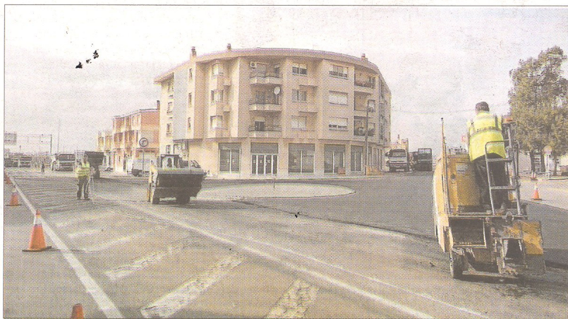
Construcció de la nova rotonda a la població de l'Aldea. FOTO: JOAN REVILLAS
