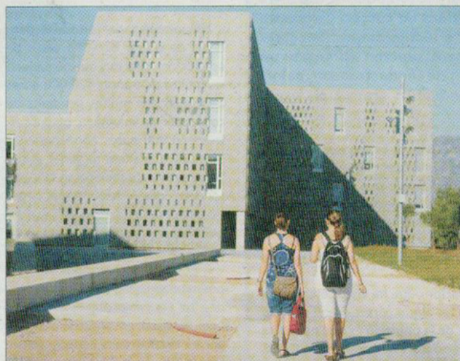
La connexió a la fibra òptica ha començat pel campus i l'hospital. / L'EBRE
