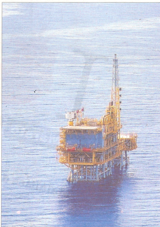
La planta marina del projecte Castor, situada davant la costa d'Alcanar i Vinaròs. FOTO: JOAN REVILLAS
