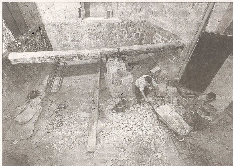
Sala de la planta baixa del Palau Episcopal on es realitzen les obres per adequar-hi un ascensor. FOTO: J. REVILLAS
