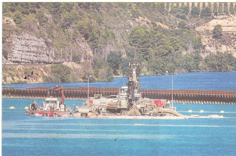
Treballs de retirada dels fangs contaminats a l'embassament de Flix. FOTO: JOAN REVILLAS
