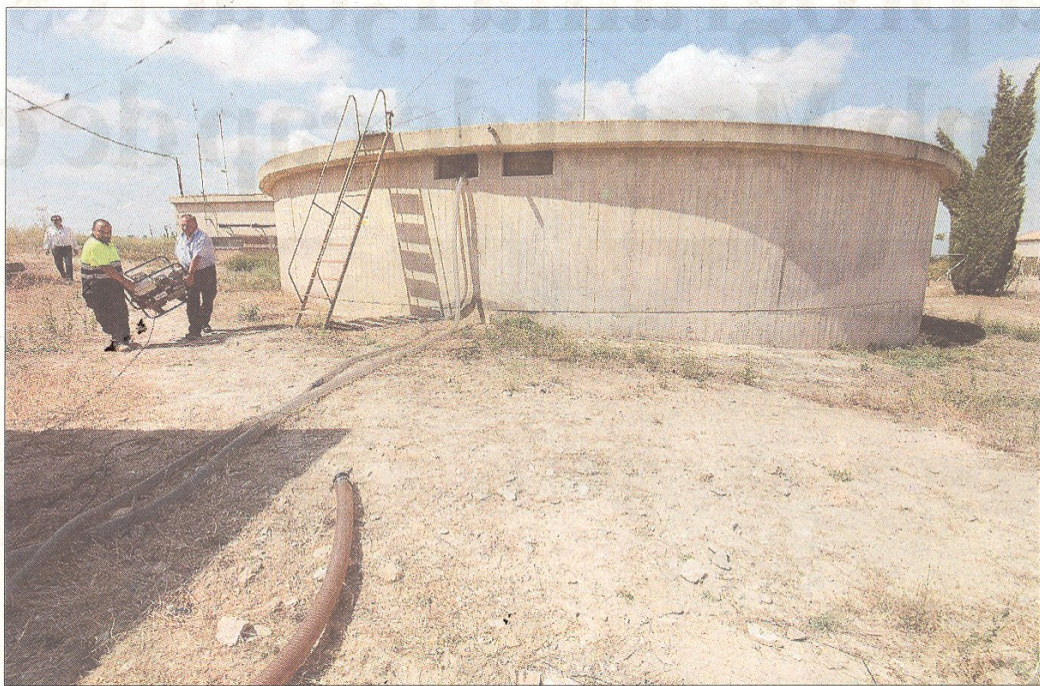
Operaris preparen el dipòsit de la Pobla de Massaluca per l'arribada de les cisternes, ahir. FOTO: JOAN REVILLAS
