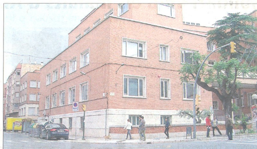
En el moment de la seua inauguració, l'ambulatori era el centre més modern de Tortosa, que ja comptava amb una extensa dotació sanitària.
