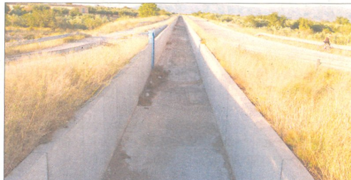
Dins del llit abandonat del que havia de ser el canal Xerta-Càlig es va construir el nou canal Xerta-Sénia, avui a meitat fer, amb obres que comencen a deteriorar-se, com les basses d'Ossera.
