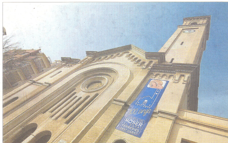
Façana de l'església del Roser, al barri de Ferreries. FOTO: JOAN REVILLAS
