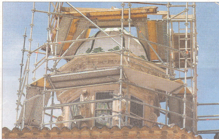
Estat de la restauració de la coberta de la capella de la Cinta, a la catedral, ahir al migdia. FOTO: JOAN REVILLAS
