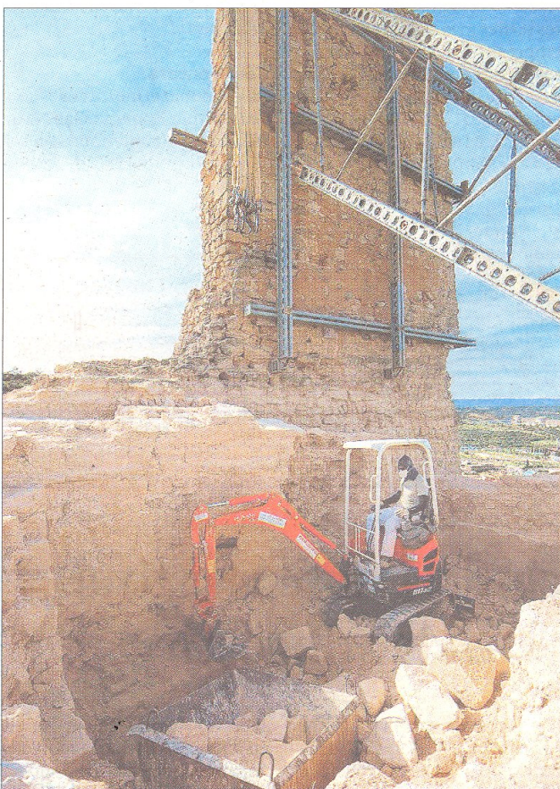
Una màquina excavadora treballa a l'interior de les restes descobertes del castell templer d'Ascó. FOTO: JOAN REVILLAS
