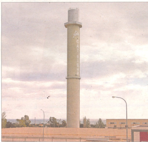
El CAT ha anunciat que preveu invertir 10 milions d'euros en reparar les canonades afectades per un procés de carbonització.
