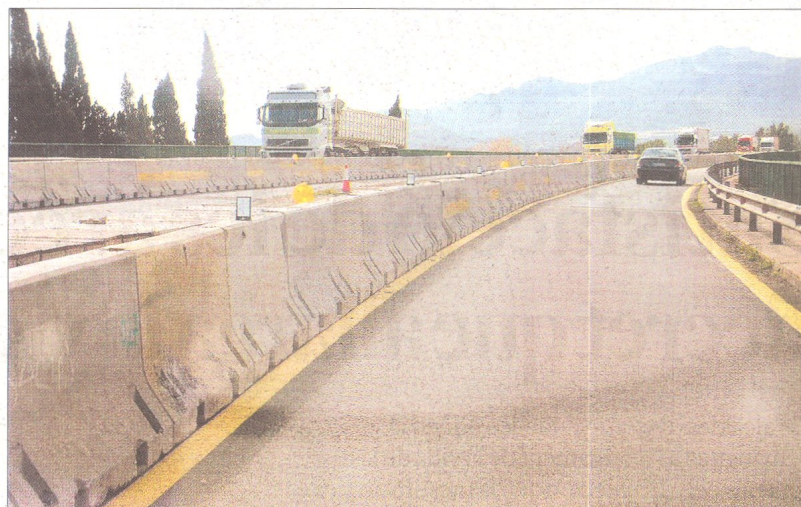
S'està construint una nova mitjana al pont de la N-340 sobre l'Ebre, a Amposta. FOTO: JOAN REVILLAS
