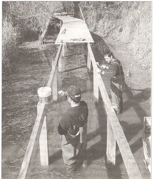
Dos operaris, ahir al migdia, mentre reparaven un tram de l'itinerari verd al bosc de ribera de la Reserva de Sebes, a Flix. FOTO: JOAN REVILLAS
