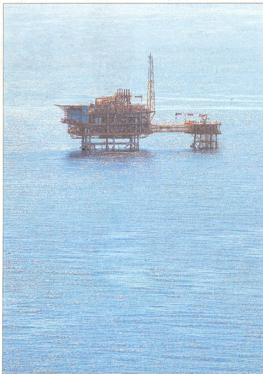
Panoràmica de la planta marina del projecte Castor, situada davant les costes de Vinaròs i Alcanar. FOTO: JOAN REVILLAS
