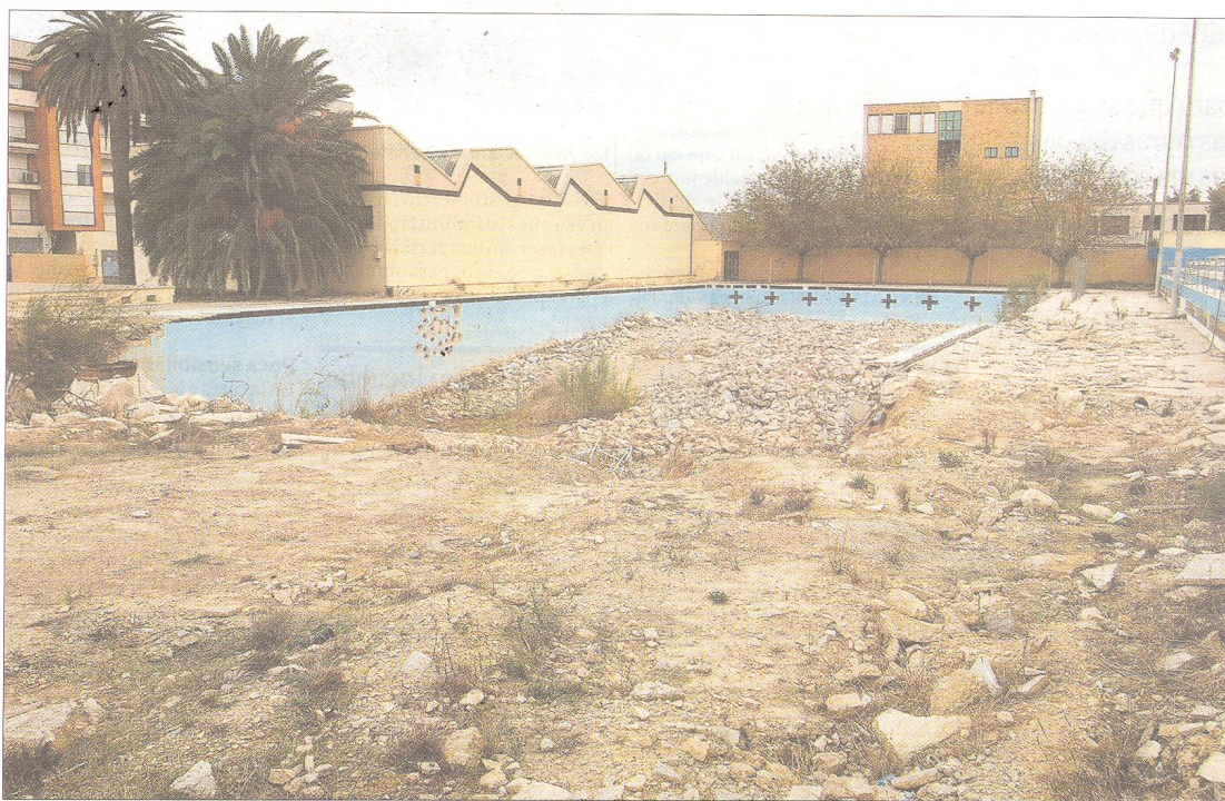
A la primavera de 2011 s'enderrocà la piscina descoberta per ubicar-hi el complex d'aigües que finalment ha quedat descartat. FOTO: JOAN REVILLAS
