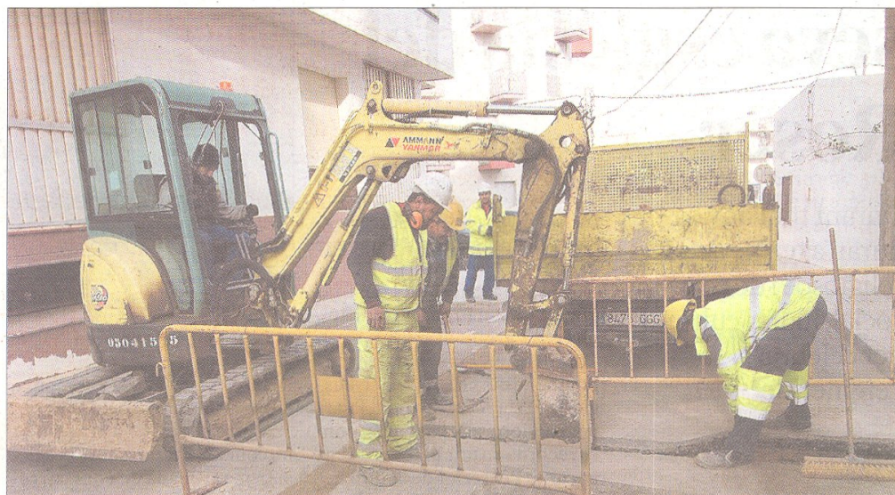
Obres de la xarxa general de gas natural a l'Ampolla, ahir. FOTO: JOAN REVILLAS
