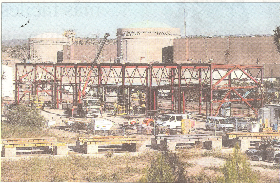
Imatge de l'estat de construcció del magatzem que acollirà els equips portàtils d'emergència. FOTO: ANAV
