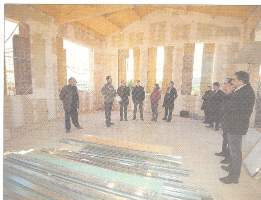
Estat de les obres del tanatori municipal de Móra la Nova, durant la visita realitzada ahir per les autoritats municipals. FOTO: JOAN REVILLAS
