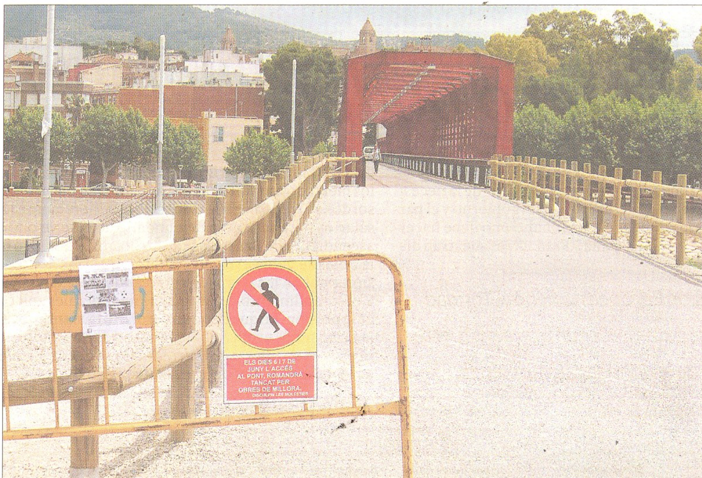
L'antic pont del tren de Tortosa s'ha reconvertit en via verda. FOTO: JOAN REVILLAS
